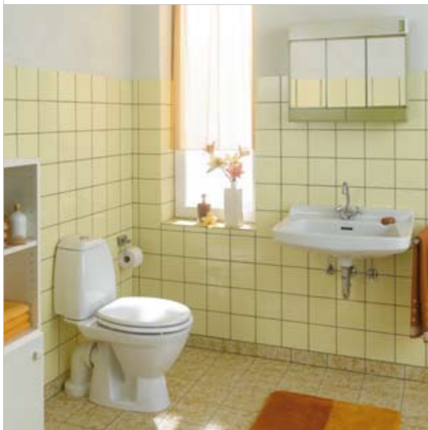
Badrum före renovering
