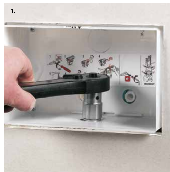
1 Höjden justeras med en justerskruv som är placerad bakom spolplattan. Genom att ta av spolplattan är det enkelt att justera toalettens höjd med upp till 8 cm.
