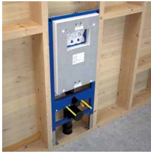
Ramen monteras med vinkeljärn i toppen och med skruvar mot golvregel, samt i de färdigborrade hålen i sidan på ramen mot stående reglar.
